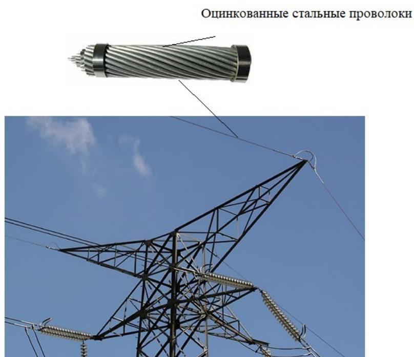
**Рисунок 3.1 – Грозозащитный трос: сталь или сталь-алюминий Для линий 110 кВ и выше на стальных и ж/б опорах**
